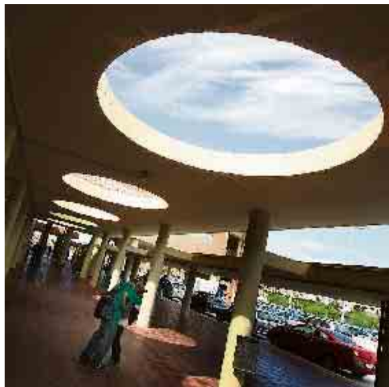
Las cubiertas dejan pasar el agua cuando llueve. ■ ALVARO CABRERA
